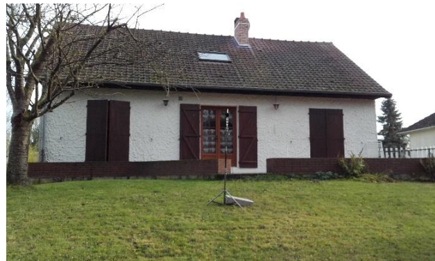
Emplacement du microphone pour la mesure au point 3
